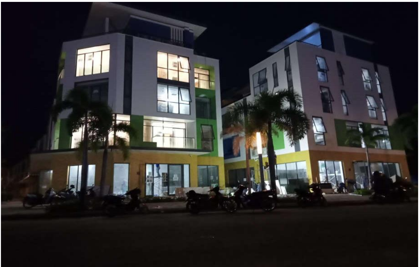
Hình ảnh thi công ban đêm
